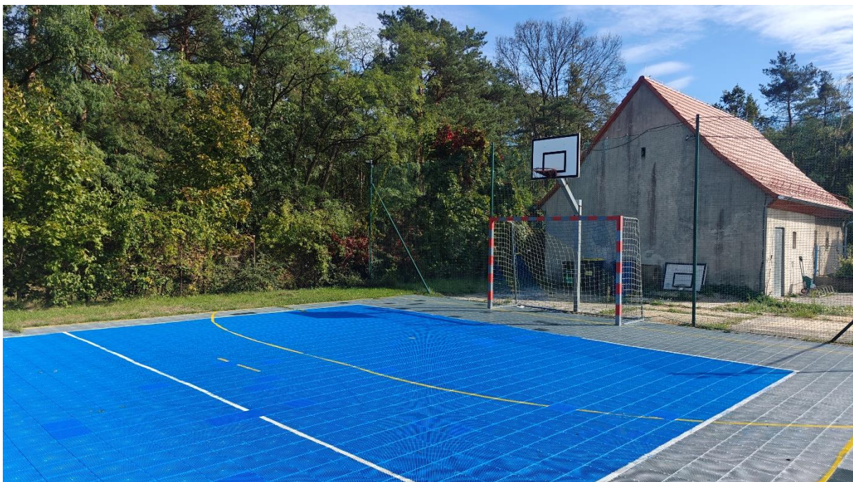
Renowacja boiska wielofunkcyjnego w Suchym Borze
