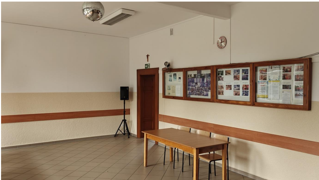
Malowanie pomieszczeń świetlicy wiejskiej
