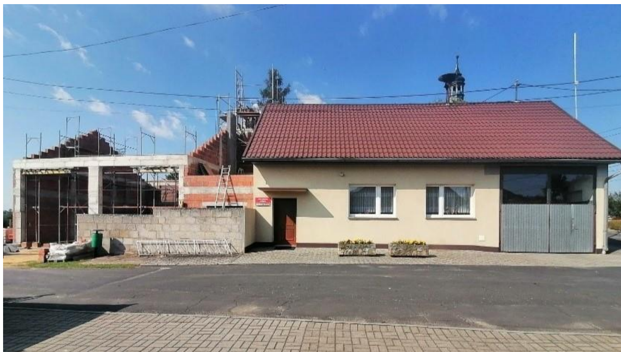
Stan surowy budynku OSP w Dębiu
