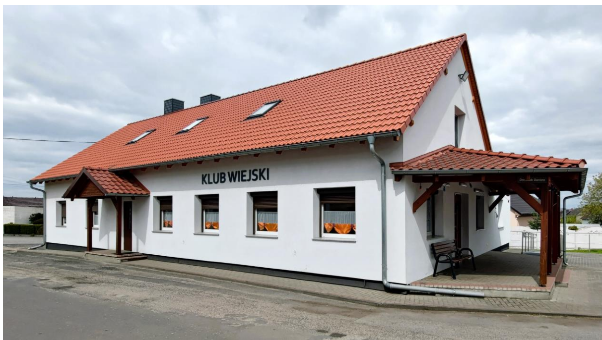
Docieplenie budynku klubu wiejskiego w Dańcu
