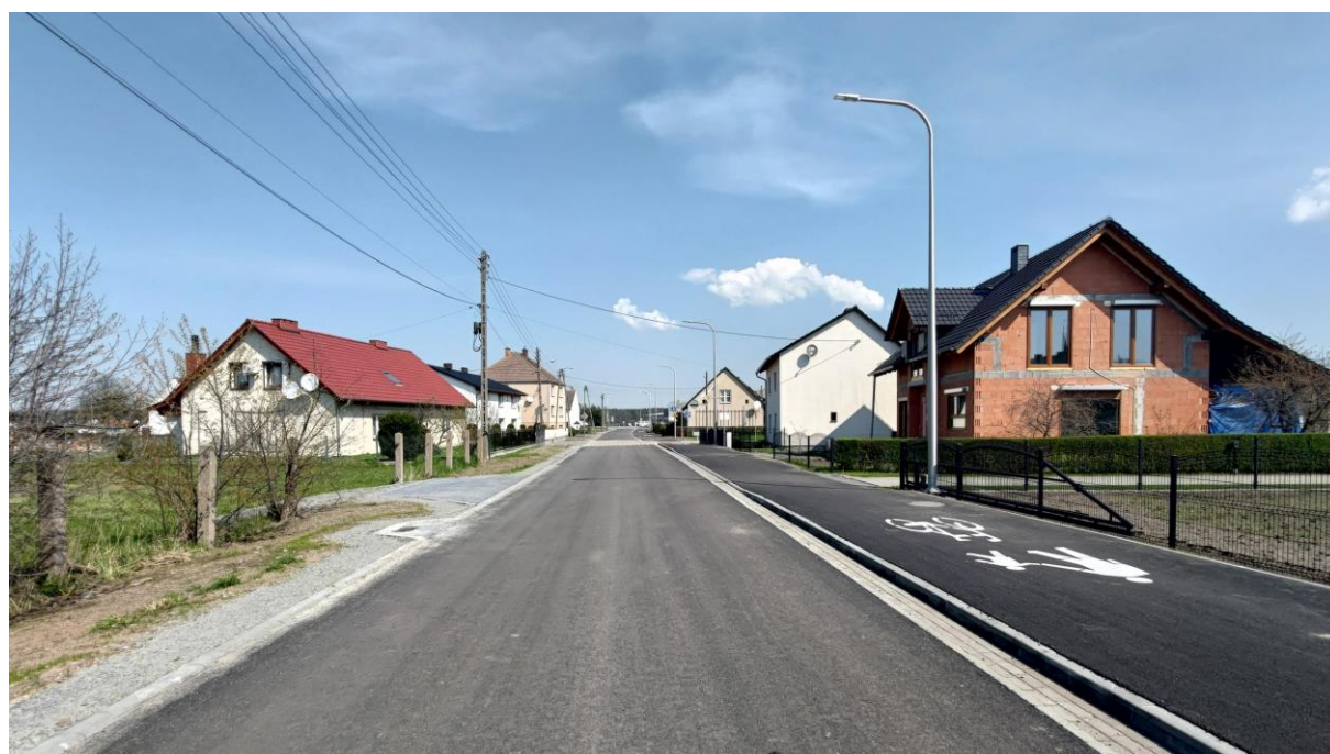
Droga gminna ul. Koterska w Chrzęstowicach
