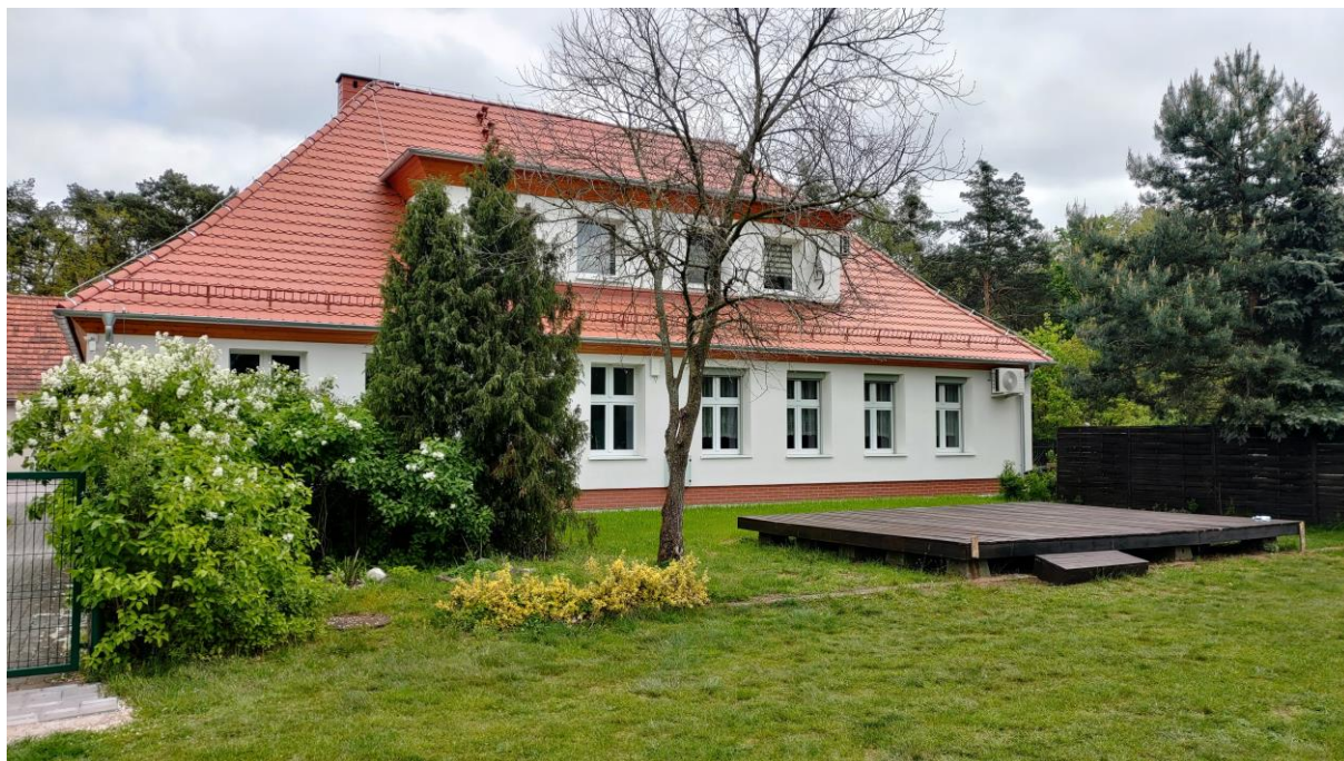
Budynek świetlicy i mieszkań komunalnych w Suchym Borze
