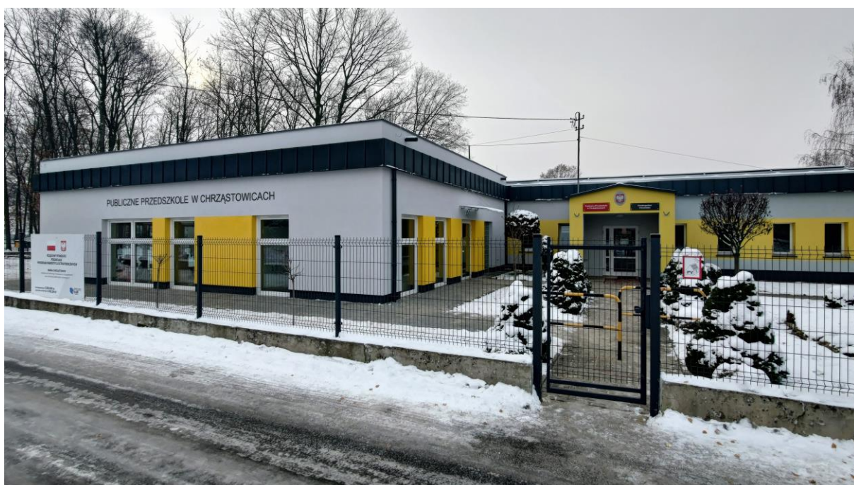
Rozbudowana część budynku Publicznego Przedszkola w Chrzastowicach
