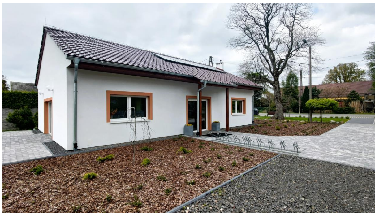
Zagospodarowanie terenu i zakup wyposażenia do świetlicy wiejskiej w Niwkach
