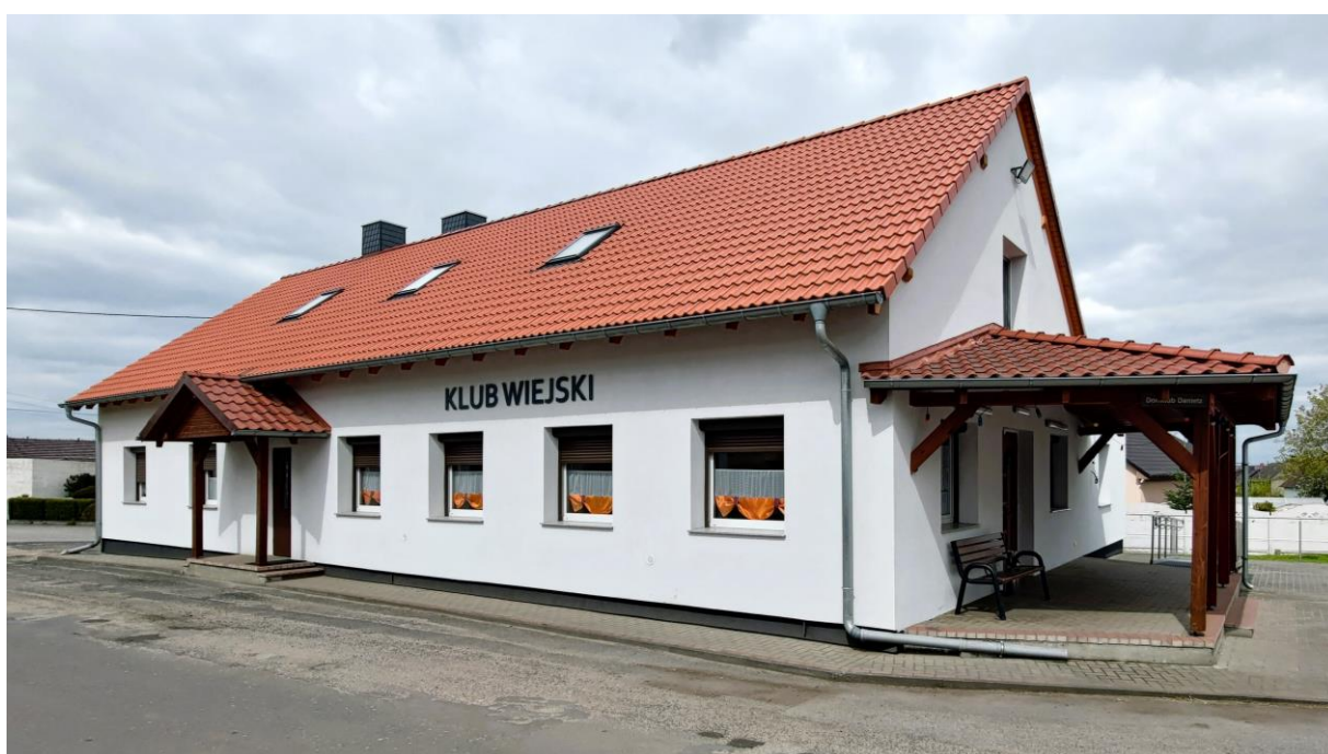
Docieplenie budynku klubu wiejskiego w Dańcu
