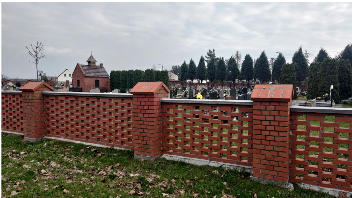
Remont ogrodzenia cmentarza komunalnego w Chrzastowicach
