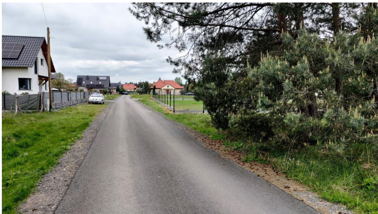
Wykonanie nawierzchni asfaltowej ul. Makowej w Suchym Borze
