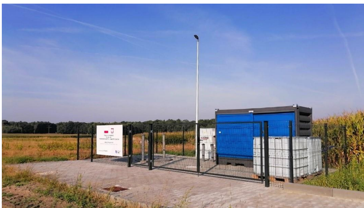
Budowa kanalizacji i przepompownia ścieków w Dańcu
