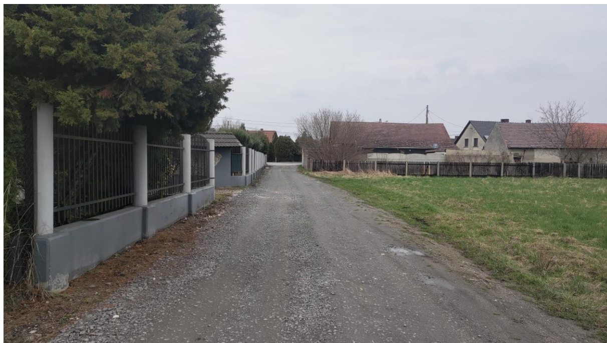
Utwardzenie ul. Uroczej w Lędzinach
