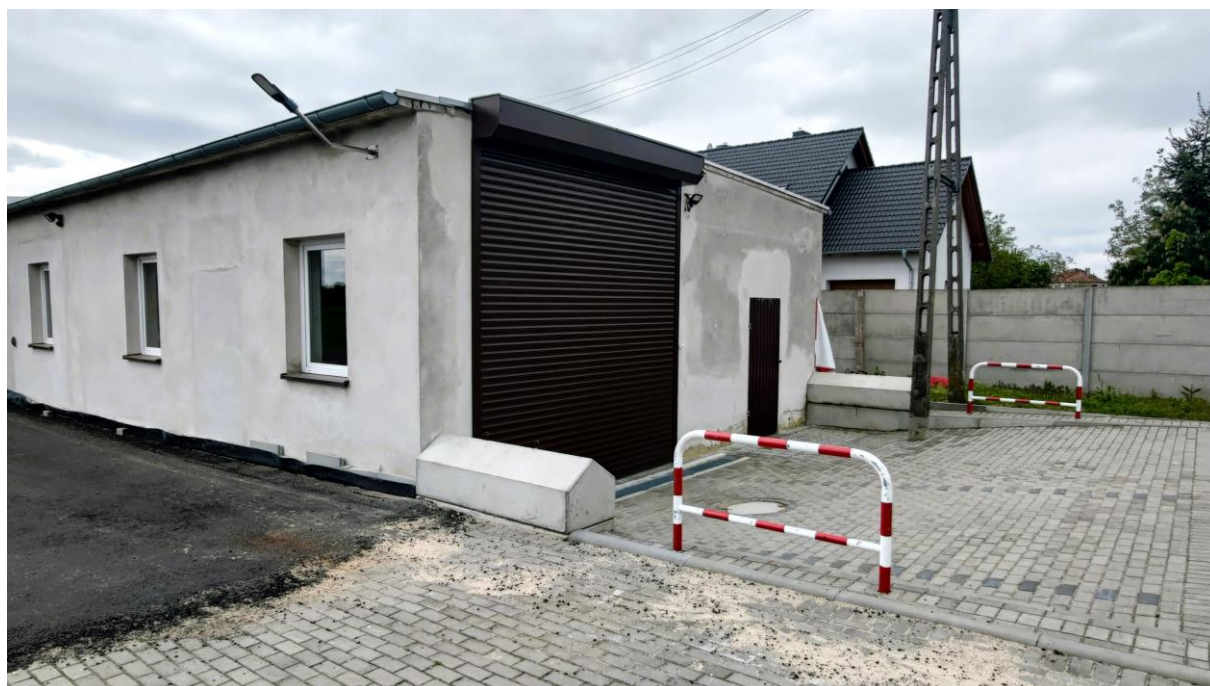
Remont budynku gospodarczego na terenie placu samorządowego przy ul. Kolonia 12 w Dębskiej Kuźni
